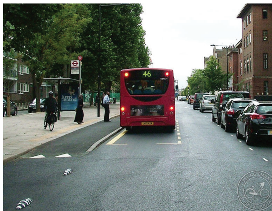
Figura 33 | Ponto de ônibus estilo Copenhagen, em Londres: a ciclovia é elevada e as marcações indicam que os ciclistas devem dar preferência aos passageiros
