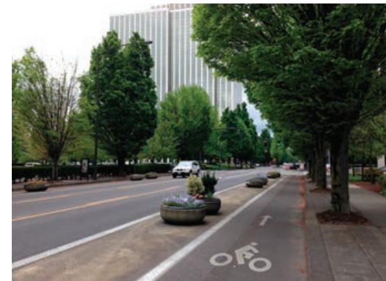
Figura 21 | Ciclovia protegida por buffers e paisagismo em Portland, Estados Unidos
