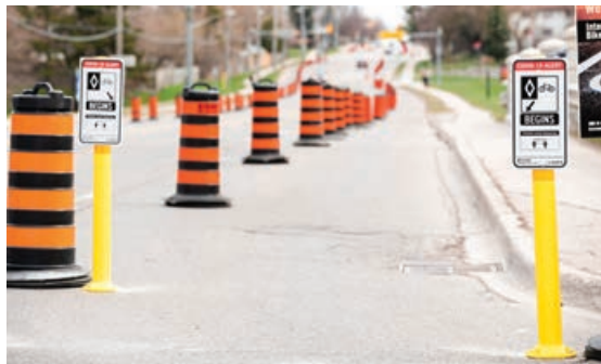
Figura 19 | O uso de cilindros canalizadores evita ferimentos graves caso os ciclistas atinjam os separadores temporários (Brampton, Canadá)
