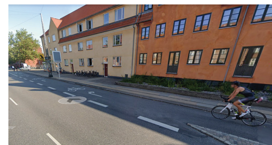
Figura 28 | Fim da zona de buffer de uma ciclovia, permitindo que bicicletas e tráfego de conversão se misturem antes da interseção, Dinamarca
