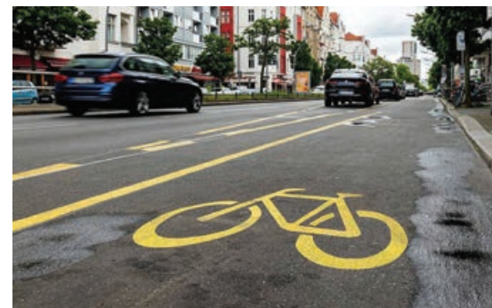
Figura 11 | Uma ciclovia em Berlim, na Alemanha, foi ampliada para permitir que os ciclistas mantenham distanciamento físico uns dos outros, enquanto a largura das faixas de carros foi reduzida
