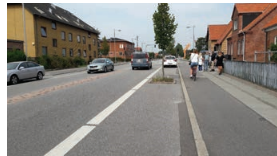
Figura 10 | Em Nykøbing Falster, na Dinamarca, uma ciclovia localizada ao lado da calçada e separada da faixa de veículos por uma faixa de estacionamento e um meio-fio
